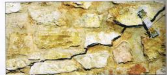
Fig. IV-6 IDEM – Surveillance des fissures.
