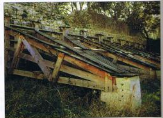
Fig. IV-5 IDEM – Étalement du mur sud du verger.
